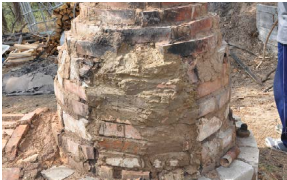
80. Камера для обжига керамики горна после закладки
