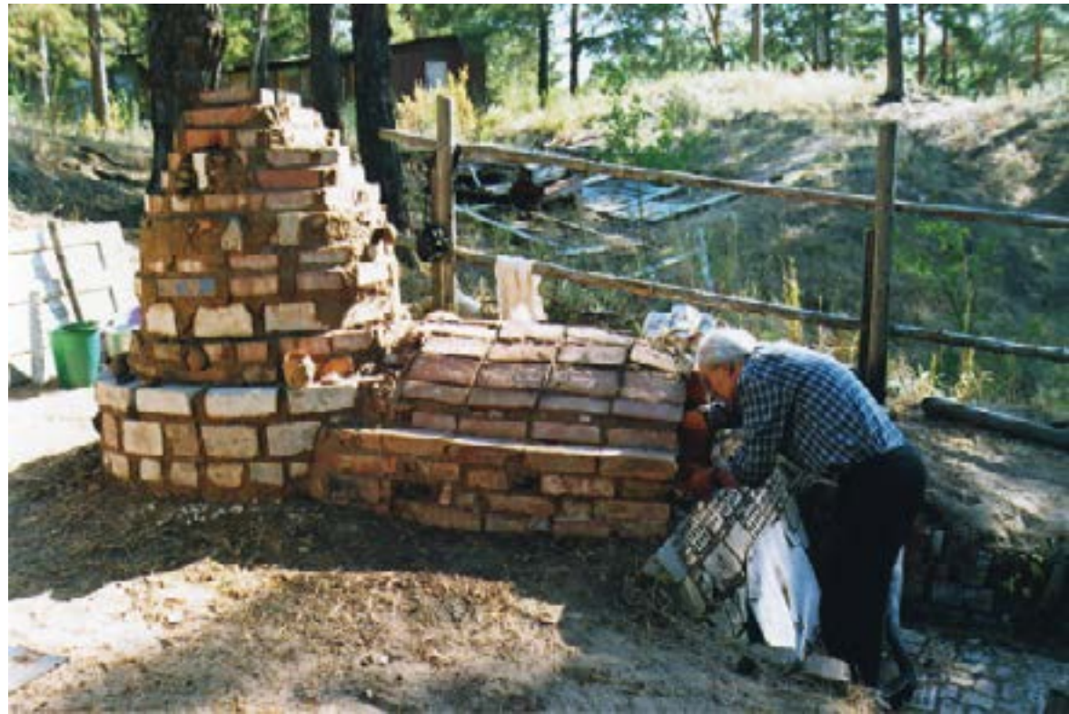
76. А.А. Бобринский ремонтирует горн
